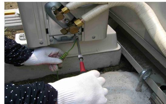
接地線をエアコンにネジ止めする作業
