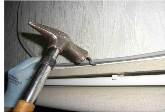
内外接続電線が冷媒配管などとともにテープで巻かれたものを壁に固定する場合
