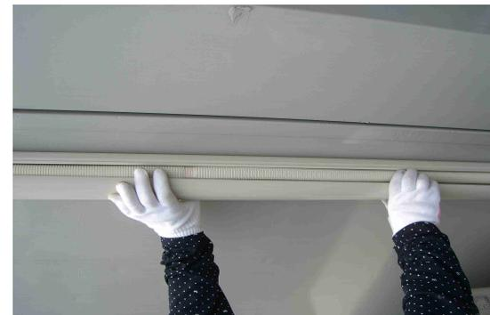
(4) 内外接続電線が造営物を貫通する部分に防護装置を取り付ける作業
