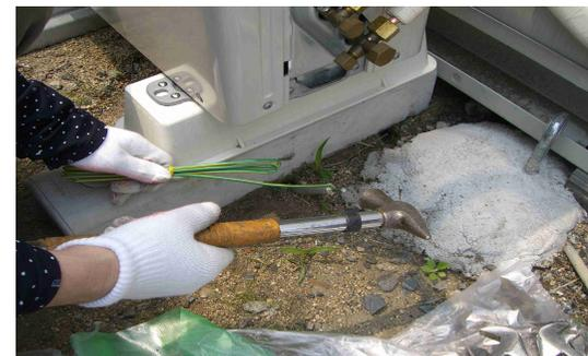
接地線を接地端子 (アースターミナル) に差し込み接続する作業
