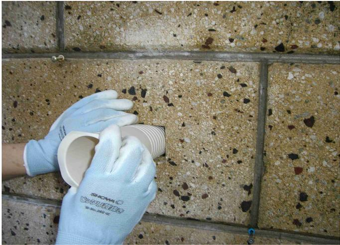
(5) 内外接続電線を防護装置の中に通す作業
