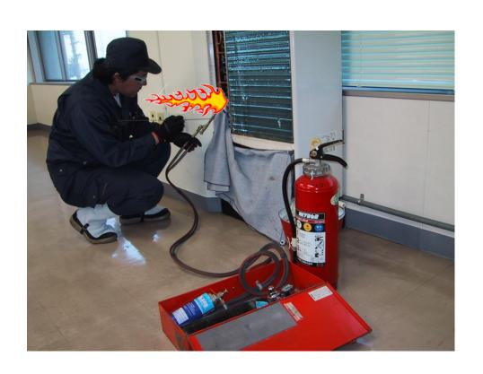
冷凍サイクルの冷媒ガスを回収した後、ガスバーナーで配管を取り外そうとした。 突然配管から冷媒ガスと オイルが炎となって、 サービスマンを襲った。
